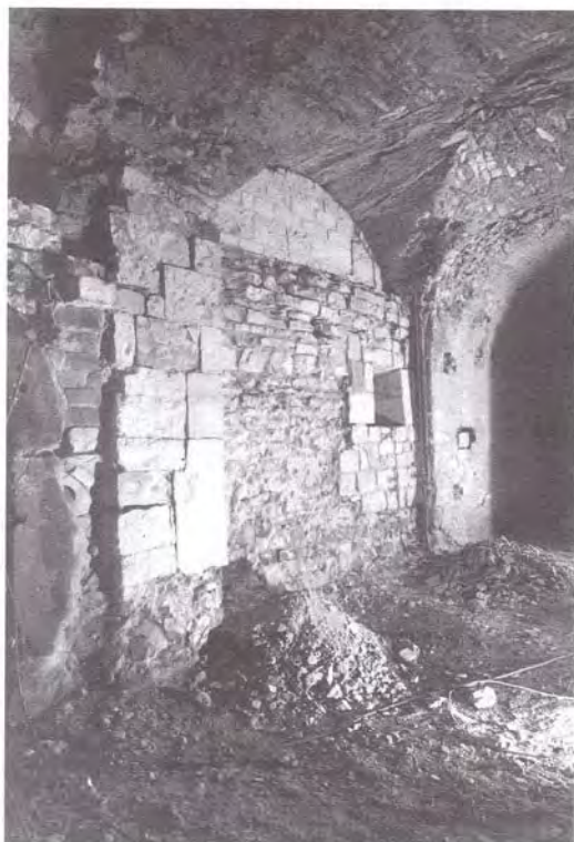
Obr. 2. Původně vnější líc západní stěny hlavní prostory domu čp. 147/I v Jilské ulici. V její horní části pod klenbou druhé románské fáze je markantní rozhraní nadzemního a základového zdiva, odhaleného přístavbou v druhé fázi. V dolní lomové části je z opracovaných kvádrů vyzděna jen partie kolem odkládací niky. Pohled od severozápadu. Foto F. Malý
