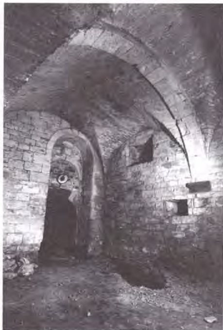
Obr. 5. Severozápadní roh hlavní místnosti domu čp. 147/I v Jilské ulici. Vlevo vnitřní převýšená vstupní nika, dosahující až ke klenbě, vpravo dole charakteristická odkládací nika. Uprostřed nahoře vnitřní špaleta okna, umístěná ve vrcholu klenbovního čela tak, aby na vnější straně ústila nad tehdejší úroveň terénu. Pohled od jihovýchodu.
