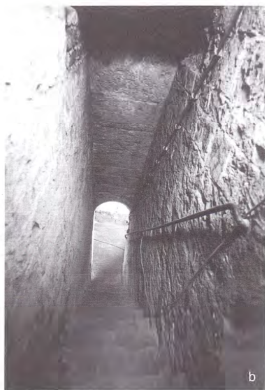
Obr. 4 a, b. Schodiště v síle zdi mezi 1. a 2. podlažím románského domu čp. 165/I v Karlově ulici. Pohled zvenčí a zevnitř. Foto F. Malý
