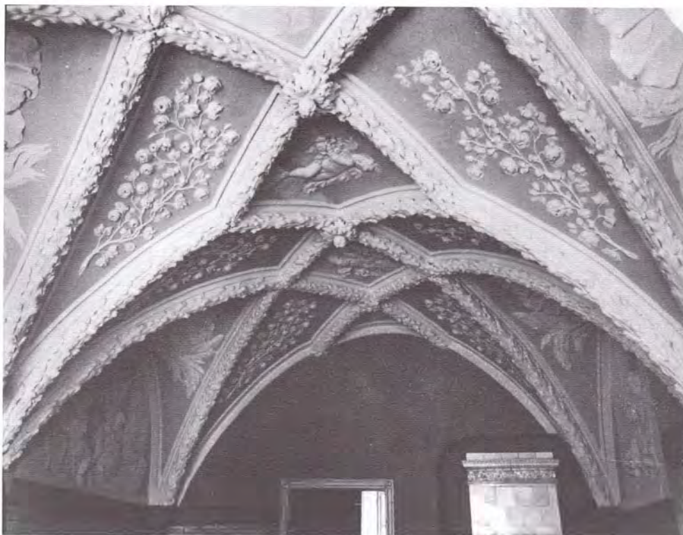
Ryc. 9. Sklepienie pomieszczenia na pierwszym piętrze w trakcie frontowym domu przy ul. Szczepańskiej 1. Fot. I. Kriegera z końca XIX w., zbiory Muzeum Historycznego Miasta Krakowa, nr inw. 1671/K
