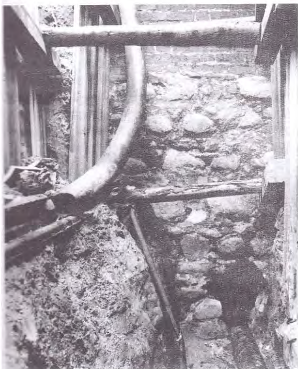
Ryc. 23. Wrocław. Rynek. Wykop III P45/46, zewnętrzne lico muru frontowego kamienicy gotyckiej. Fot. T. Gąsior Abb. 23. Breslau. Ring. Grabungsfläche III P45/46, äußere Frontmauerflucht des gotischen Bürgerhauses. Foto von T. Gąsior
