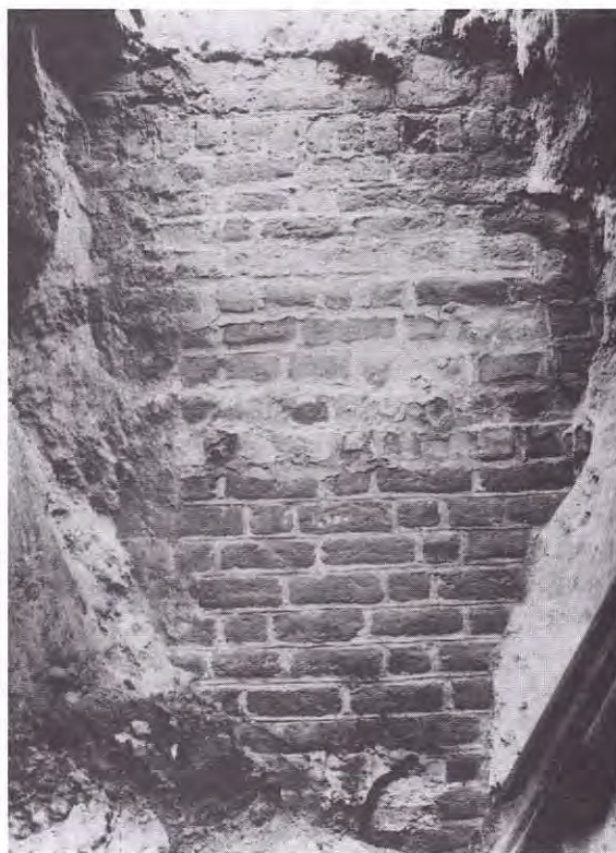
Ryc. 48. Wrocław. Rynek. Wykop III P52b, mur frontowy kamienicy z XIII w. Fot. T. Gąsior Abb. 48. Breslau. Ring. Grabungsfläche III P52b, Vordermauer des Bürgerhauses aus dem 13. Jh. Foto von T. Gąsior
