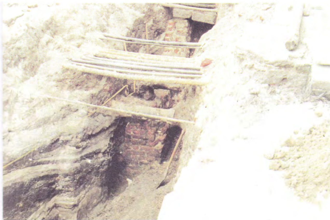
Ryc. 9. Wykop IV/2a. Profil ściany południowej z murem przedproża
