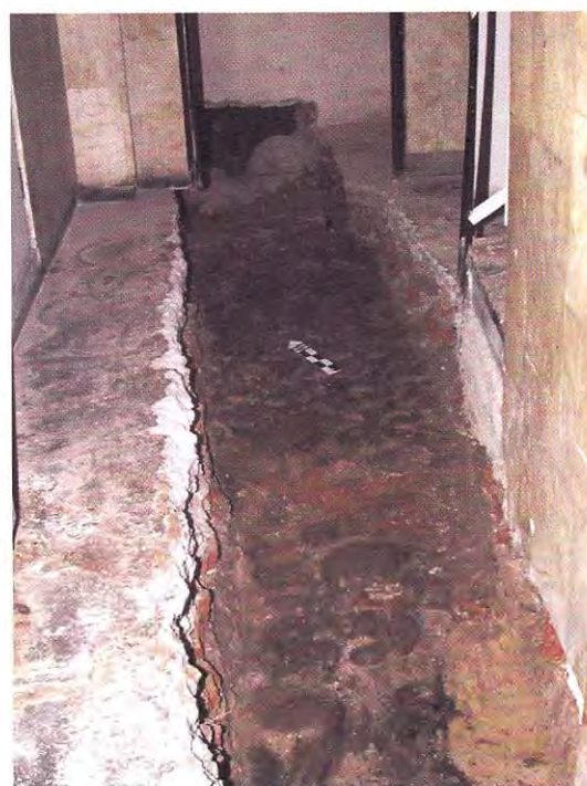
Ryc. 176. Wrocław, Rynek 50, sektor 2: rejon klatki schodowej, bruk ceglano-kamienny (C1 a ). Fot. P. Guszpit Abb. 176. Breslau, Ring 50, Sektor 2: Bereich des Treppenhauses. Stein- und Backsteinpflaster (C1 a ). Foto von P. Guszpit
