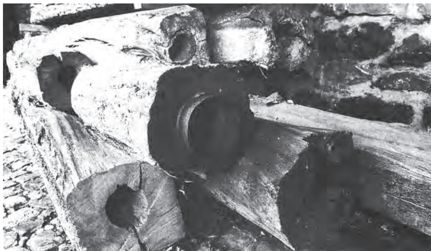
Ryc. 2. Rzymskie drewniane przewody wodociągowe z Akwizgranu (Hodge 1992, s. 109)
