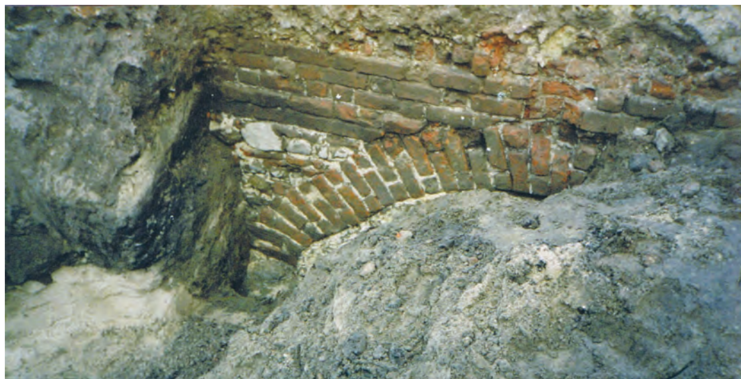
Ryc. 9. Wrocław, ul. Ducha Świętego. Partia fundamentowa muru otaczającego zespół szpitalno-kościelny Ducha Świętego (fot. J. Romanow)
