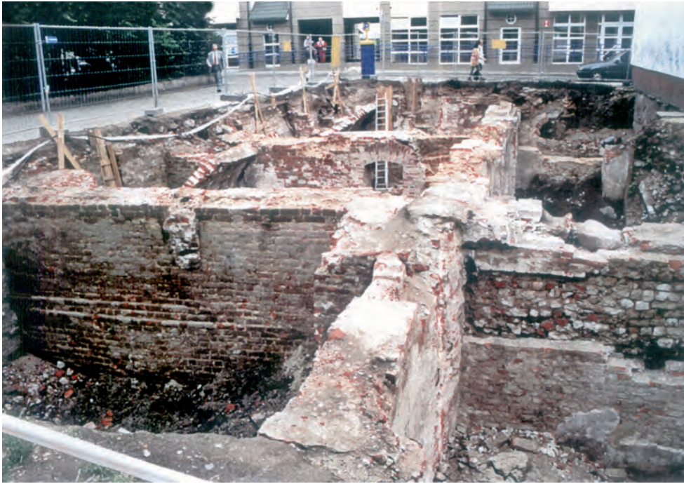
Ryc. 9. Ul. Biskupia 15-16. Widok ogólny terenu badań. Fot. P. Guszpit Abb. 9. Bischofsgasse 15-16. Grabungsgebiet. Foto P. Guszpit
