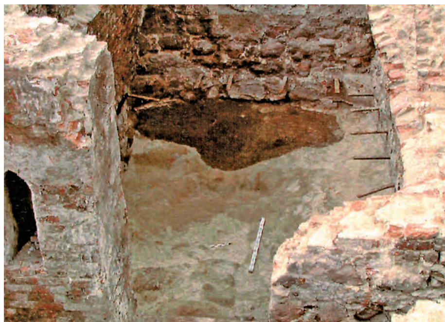
Ryc. 52. Ul. Biskupia 4-5, sektor 1, w głębi piwnicy ob. 1 – dół po wybranym piasku zasypany śmieciami. Fot. P. Konczewski Abb. 52. Bischofsgasse 4-5, Sektor 1, Ob. 1 – Als Abfallgrube genutzte Sandgrube. Foto P. Konczewski
