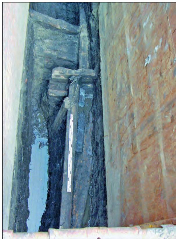
Ryc. 68. Wrocław, ul. Szewska. Wykop II, j.s. 163 na wysokości posesji nr 18, szczegóły konstrukcyjne, widok od południa. Fot. P. Konczewski
