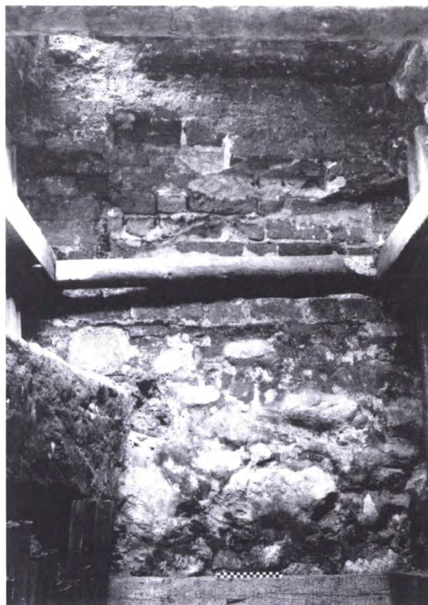
Ryc. 9. Przyłącze 38/39-40. Górna część gotyckiego fundamentu kamienicy Rynek 38. Fot. T. Gąsior
