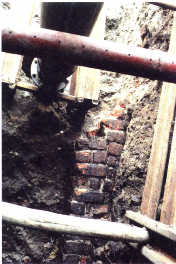
Ryc. 17. Przyłącze 39-40. Fragment łuku południowego otworu wejściowego przedproża z kamienicą Rynek 40. Fot. T. Gąsior
