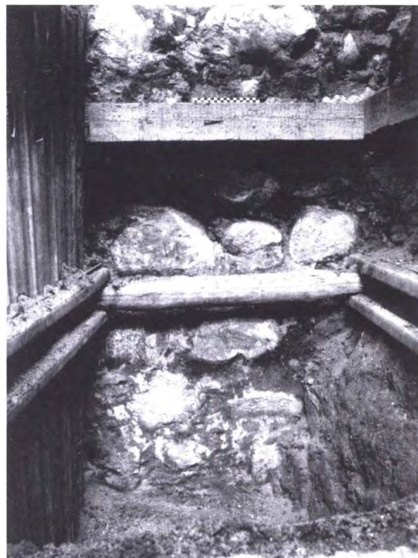
Ryc. 10. Przyłącze 38/39-40. Dolna część gotyckiego fundamentu kamienicy Rynek 38. Fot. T. Gąsior
