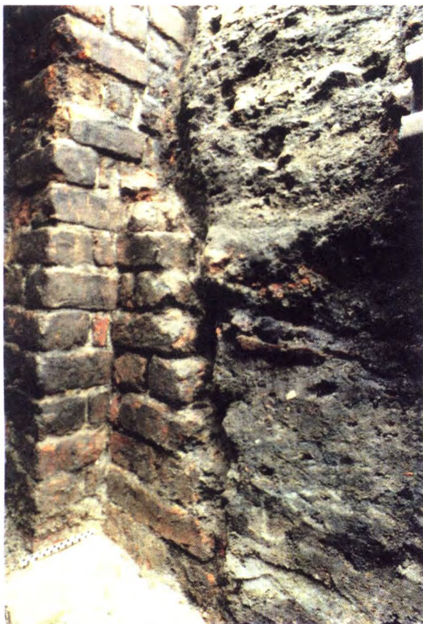
Ryc. 16. Przyłącze 39-40. Filar z przyporą ceglano- kamienną przedproża z kamienicą Rynek 40. Fot. T. Gąsior
