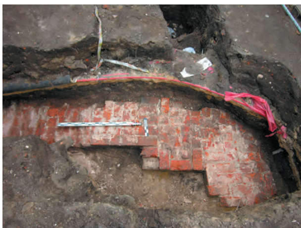
Fot. 9. Wrocław, kościół Salwatora, wykop IX. Widok narożnika NE korpusu kościoła z fazy I od strony S
