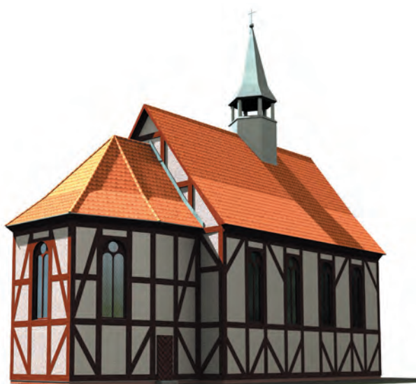
Ryc. 10. Wrocław, kościół Salwatora. Rekonstrukcja świątyni z I fazy budowlanej (1561 r.) z widoczną konstrukcją ryglową, widok południowo-zachodni. Rys. Mariusz Caban
