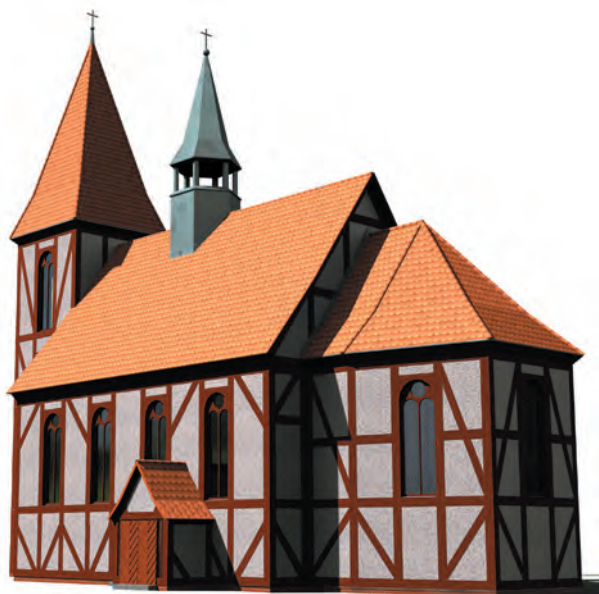
Ryc. 20. Wrocław, kościół Salwatora. Rekonstrukcja świątyni z II fazy budowlanej (1577 r.) z widoczną konstrukcją ryglową, widok północno zachodni. Rys. Mariusz Caban
