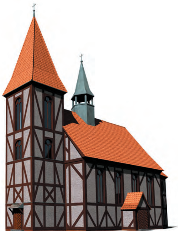
Ryc. 18. Wrocław, kościół Salwatora. Rekonstrukcja świątyni z II fazy budowlanej (1577 r.) z widoczną konstrukcją ryglową, widok północno wschodni. Rys. Mariusz Caban
